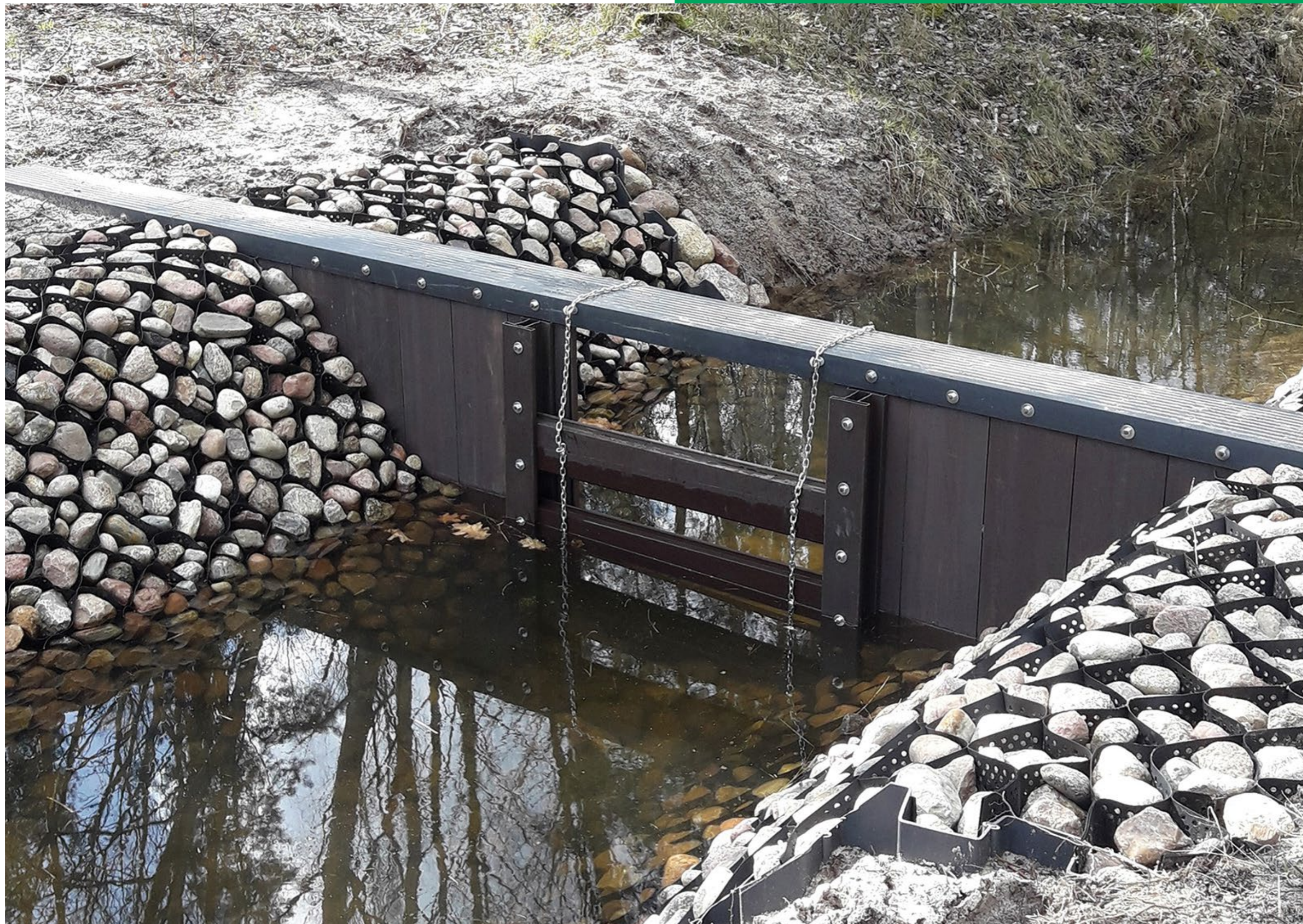
GRABÓW, POLSKA: JEDEN Z ELEMENTÓW KOMPLEKSOWEGO SYSTEMU RETENCJI KORYTOWEJ W DORZECZU PILICY.
