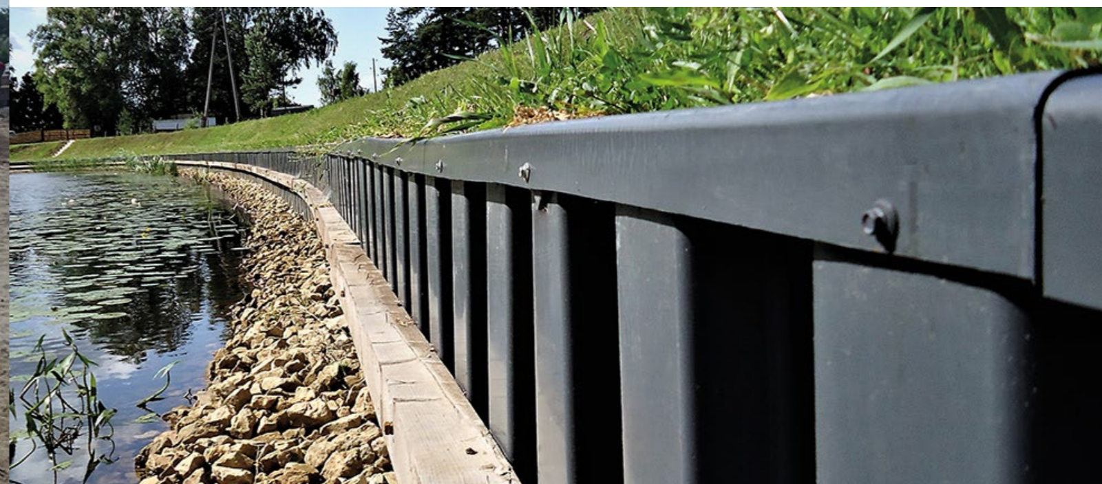
CARNIKAVA, ŁOTWA. ZABEZPIECZENIE BRZEGU ZBIORNIKA WODNEGO.
