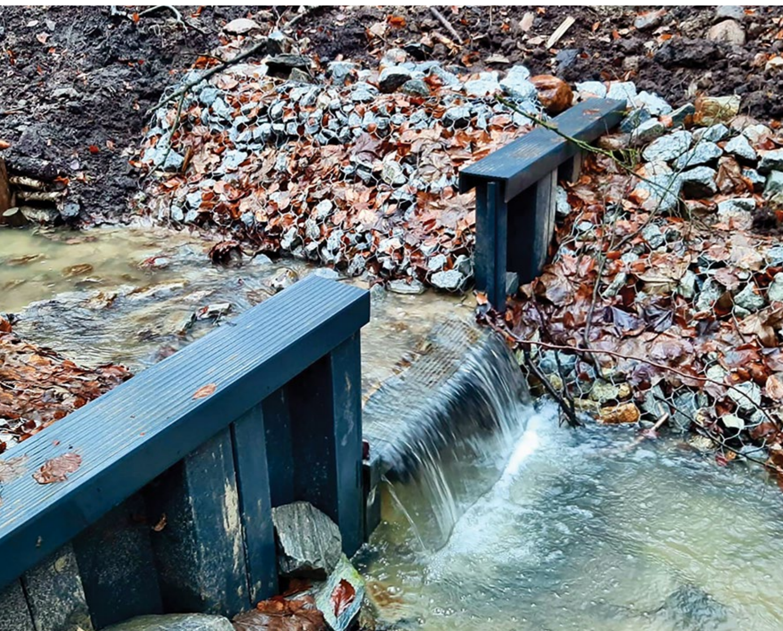
SZCZECIN, POLSKA: SYSTEM PROGÓW WODNYCH ZAINSTALOWANYCH W CELU SPOWOLNIENIA SPŁYWU WÓD POTOKU.
