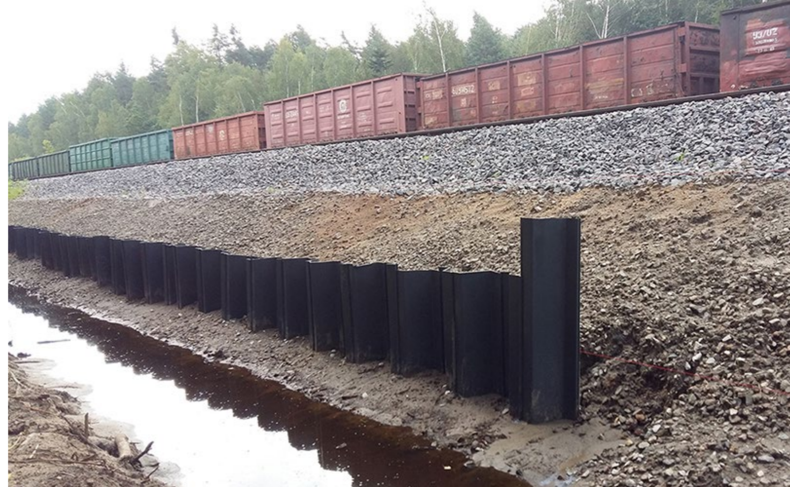
STALOWA WOLA, POLSKA: STABILIZACJA NASYPU KOLEJOWEGO.
