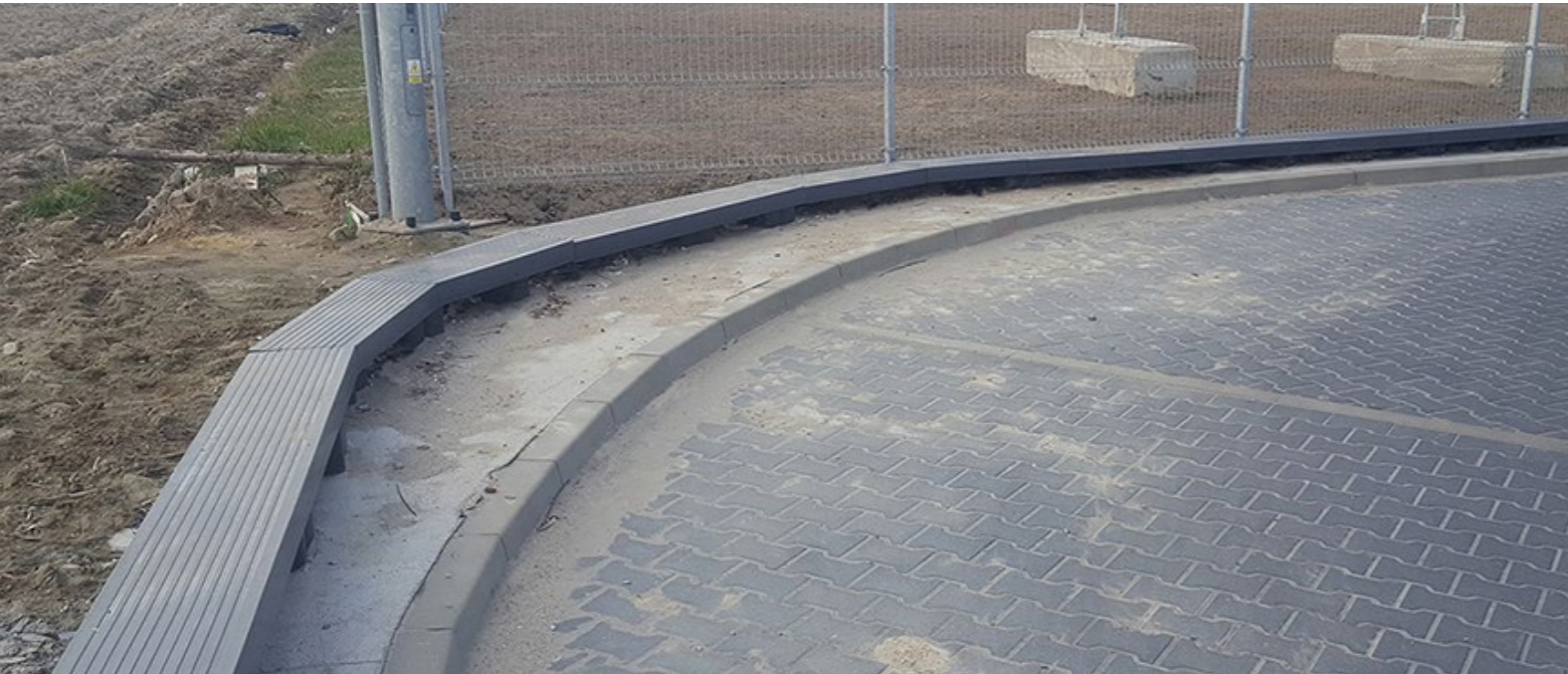
KUTNO, POLSKA: ZABEZPIECZENIE STACJI PALIW PRZED ZALEWANIEM I UKIERUNKOWANIE DROGI FILTRACYJNEJ WÓD, ABY ZWIĘKSZYĆ ZDOLNOŚCI RETENCYJNE SASIADUJĄCYCH OBSZARÓW ROLNICZYCH. SZCZELNA KONSTRUKCJA ZAPEWNIĄ OCHRONĘ PRZED SKAŻENIEM SUBSTANCJAMI CHEMICZNYMI.
