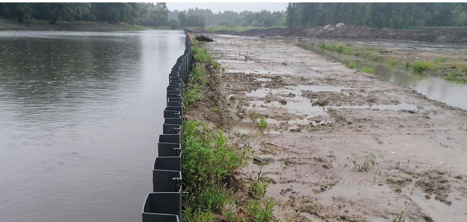
KOMORÓW, POLSKA: GRODZICE WINYLOWE Z USZCZELKĄ WYKORZYSTANE DO TYMCZASOWEGO PRZEŁOŻENIA KORYTA CIEKU WODNEGO.
