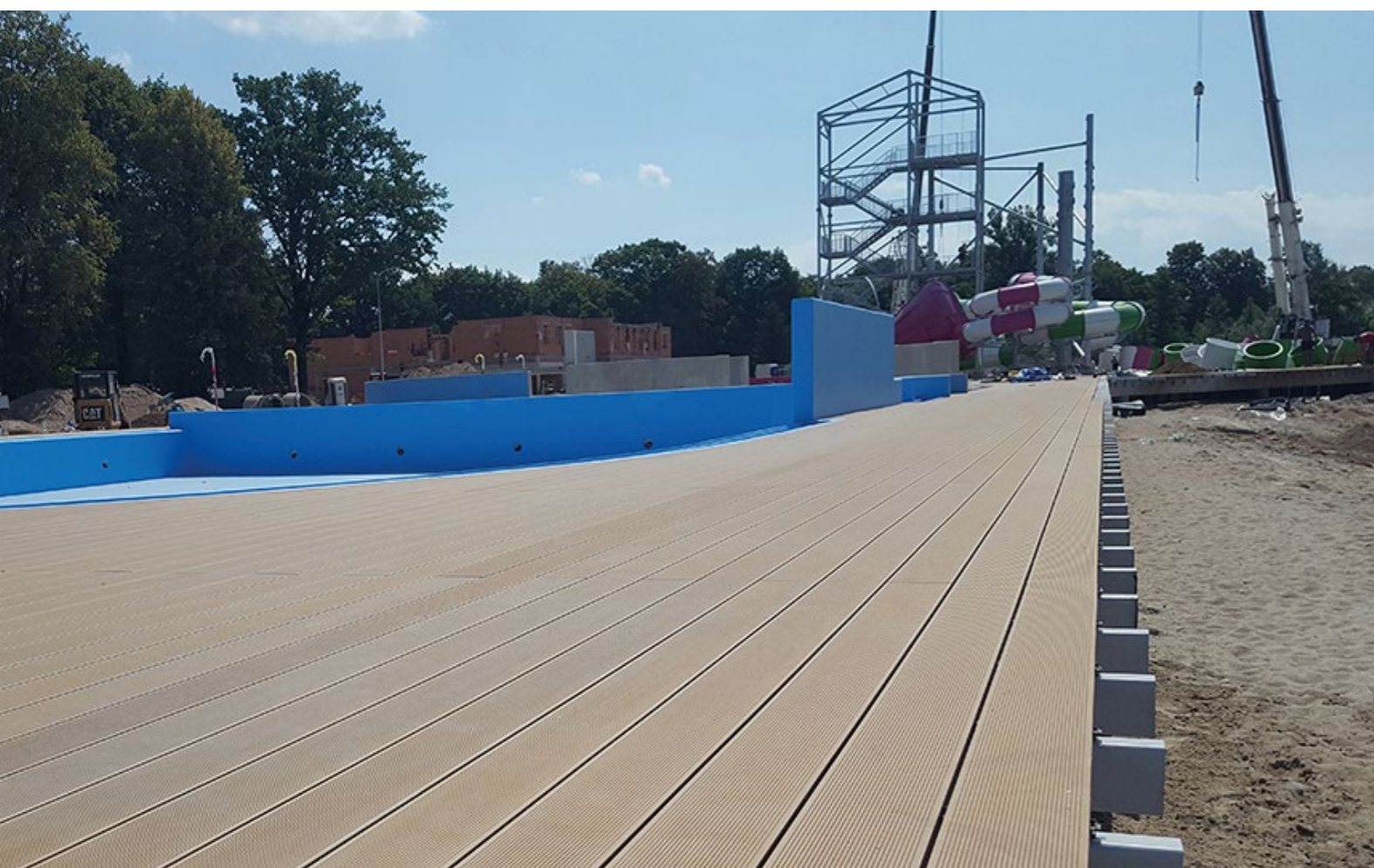
W TYM PROJEKCIE, OPRÓCZ GRODZIC ECOLOCK, ZASTOSOWANO TAKŻE DESKĘ TARASOWĄ TERRADECK PRODUKOWANĄ PRZEZ GRUPĘ PIETRUCHA.
