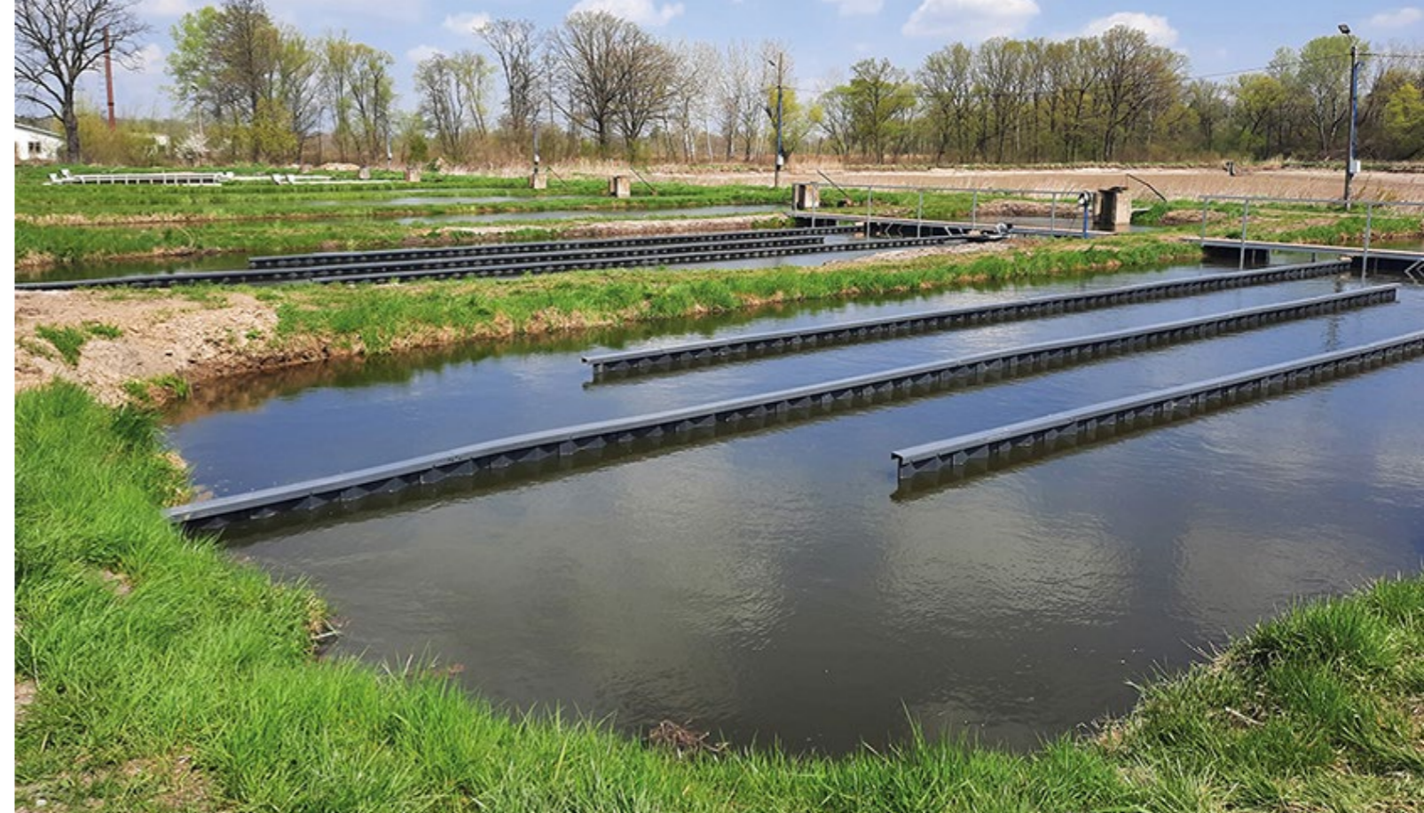
GRODZICE WINYLOWE ORAZ DESKI TARASOWE TERRADECK WYKORZYSTANO PRZY BUDOWIE INFRASTRUKTURY W OBRĘBIE KOMPLEKSU EKSPERYMENTALNYCH STAWÓW RYBACKICH W ŻABIENCU, POLSKA.
