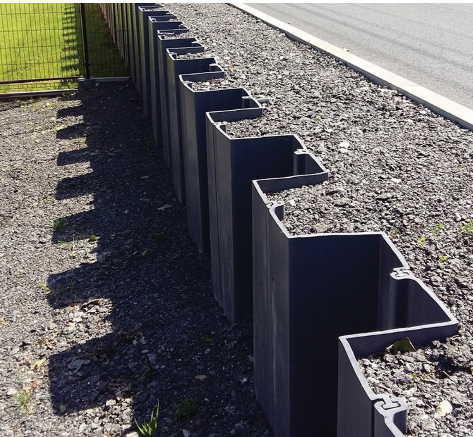
MARKLOWICE, POLSKA: ŚCIANA OPOROWA TWORZĄCA KONSTRUKCJĘ DROGI.
