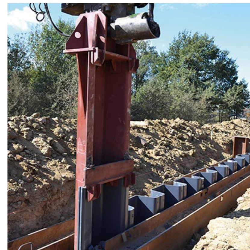
WROCLAWSKI WEZEŁ WODNY, POLSKA: WZMACNIANIE WAŁU PRZECIWPOWODZIOWEGO GRODZICAMI WINYLOWYMI - PRACE INSTALACYJNE.
