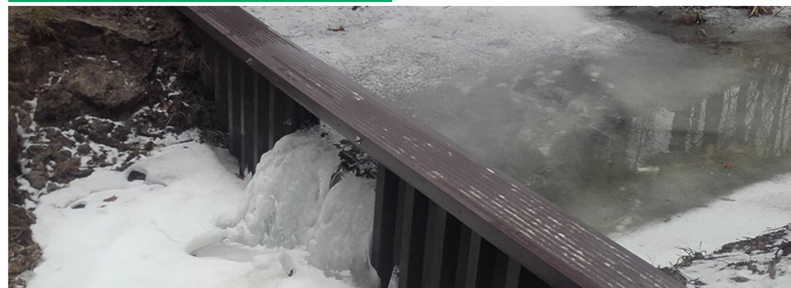
NADLEŚNICTWO PODANIN, POLSKA: ZASTAWKI WYKONANE Z PVC SĄ TRWAŁE I ODPORNE NA WARUNKI ATMOSFERYCZNE.
