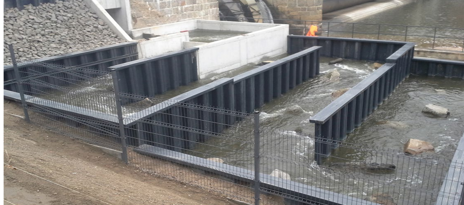
ŻAGAŃ, POLSKA: PRZEPLAWKA DLA RYB WYKONANA Z GRODZIC WINYLOWYCH WYPOSAŻONYCH W OCZEP.
