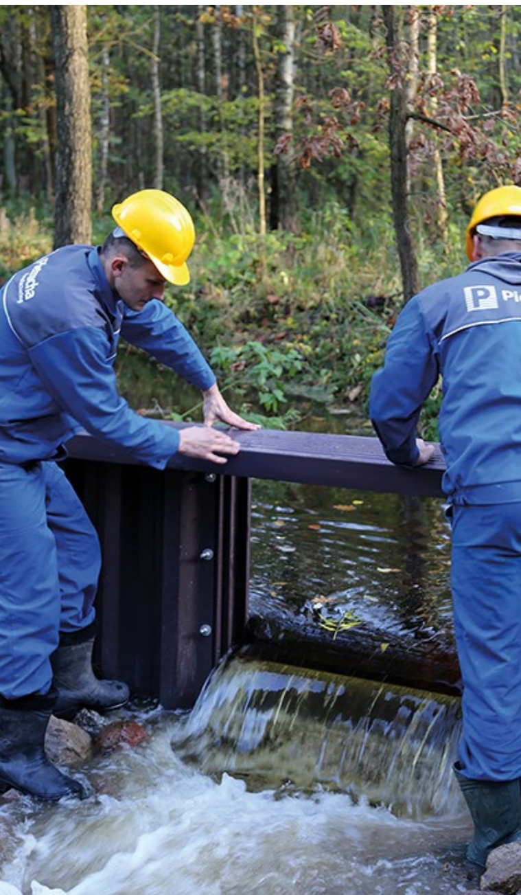
WOJ. WIELKOPOLSKIE, POLSKA: MONTAŻ ZASTAWKI MAŁEJ RETENCJI W NADLEŚNICTWIE PODANIN. OCHRONA EKOSYSTEMU LEŚNEGO PRZED WYSYCHANIEM.
