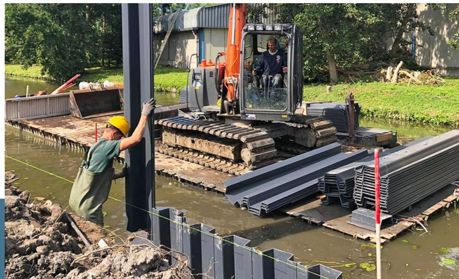
DELFT, HOLANDIA: ZABEZPIECZENIE BRZEGÓW KANAŁU.
