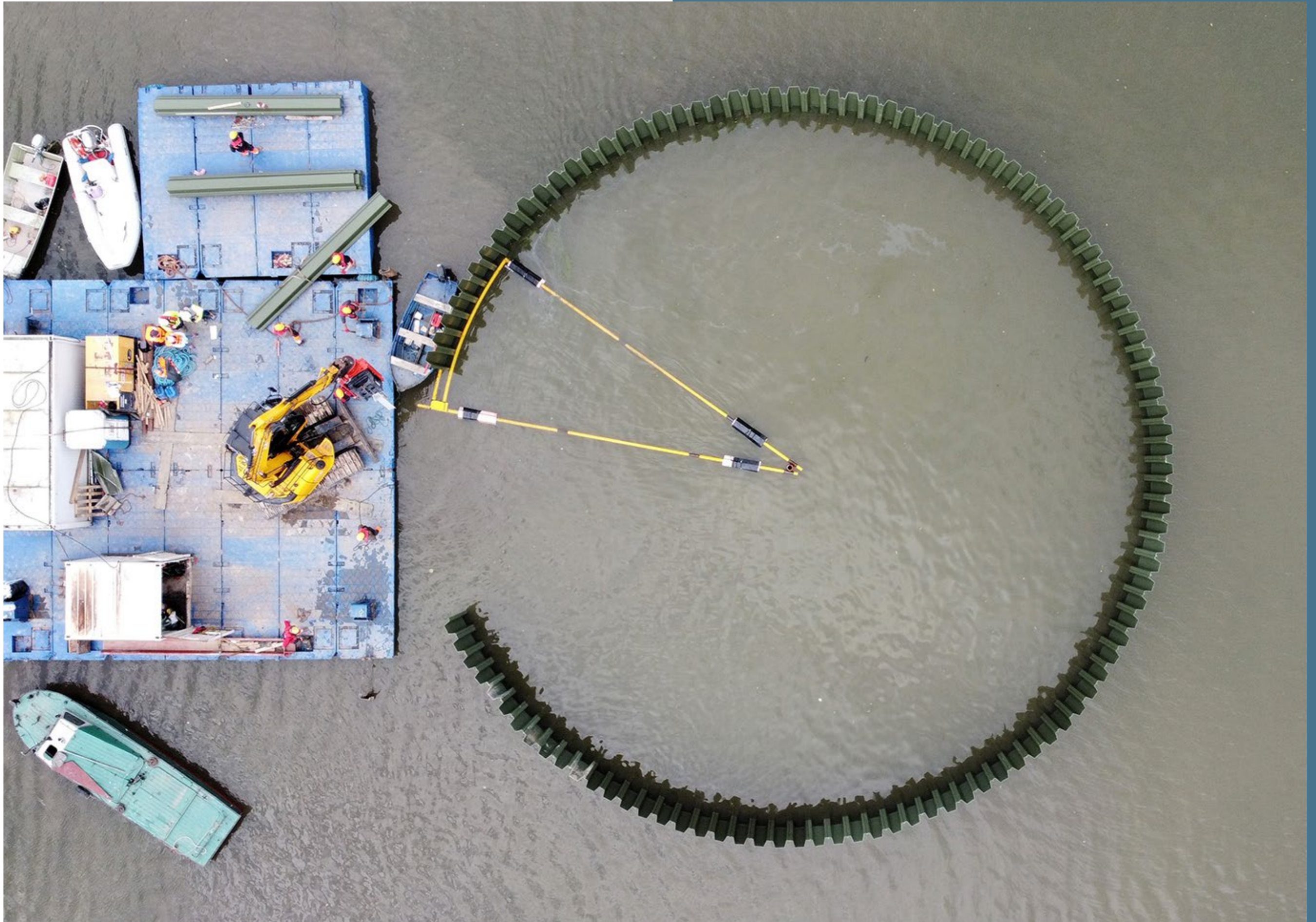
ZBIORNIK GOCZAŁKOWICKI, POLSKA: BUDOWA SZTUCZNEJ PTASIEJ WYSPY.
